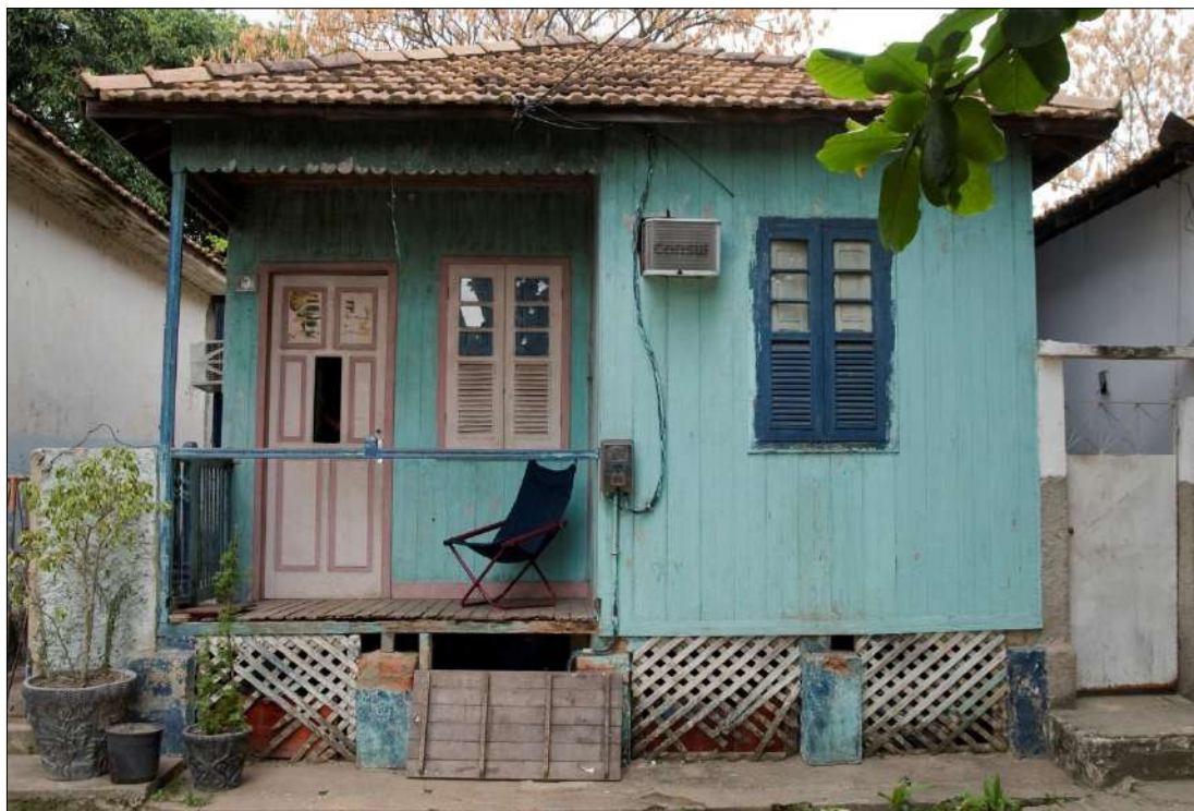
Figura 4 - Fachada de uma das casas da Vila de São Lázaro, no bairro do Caju
