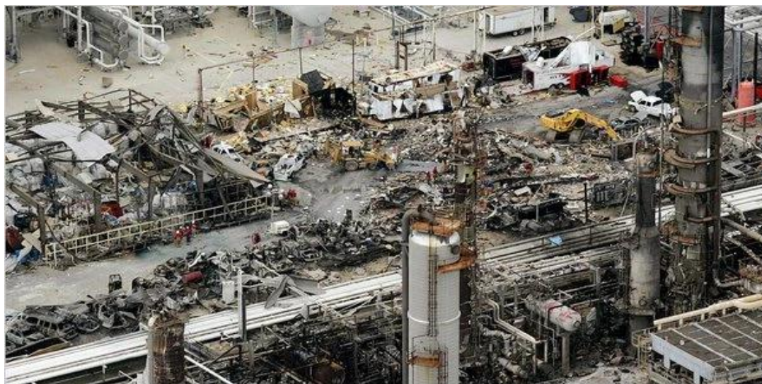
FIGURA 24 - UNIDADE DE ISOMERIZAÇÃO APÓS A EXPLOSÃO
