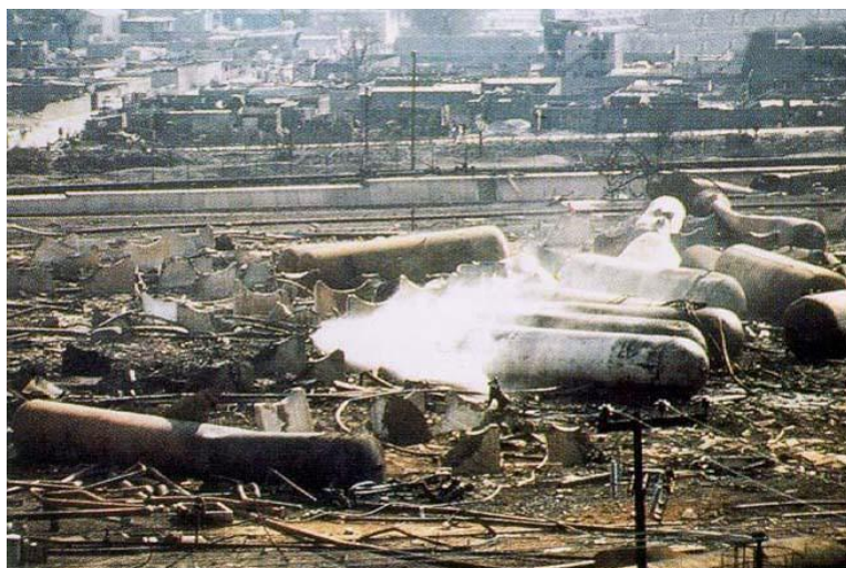
Figura 2.9: Área de tancagem destruída
