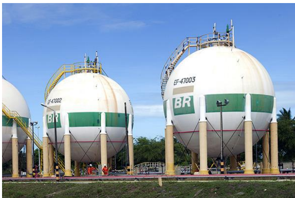
Figura 2.2: Vasos esféricos da distribuidora Petrobrás.
