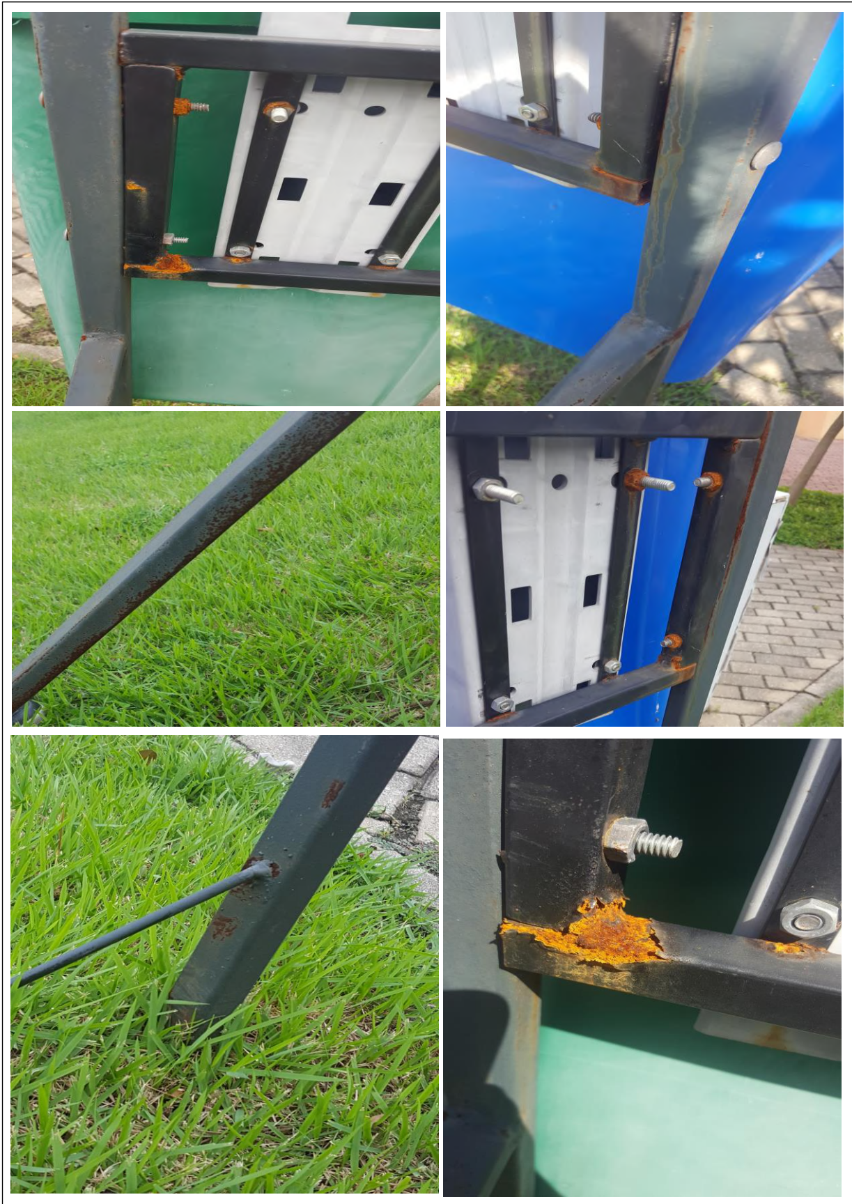
Figura 28: Processos de corrosão iniciados ou já avançados na obra, especialmente nos parafusos das lixeiras das extremidades da peça e na trava de sustentação fixada ao solo. Fonte: Acervo Pessoal
