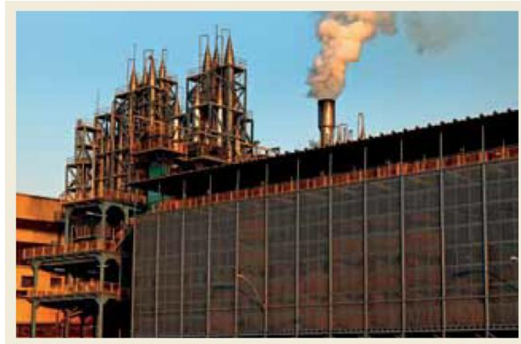
Figura 3: Silos de estocagem ( Bins )
