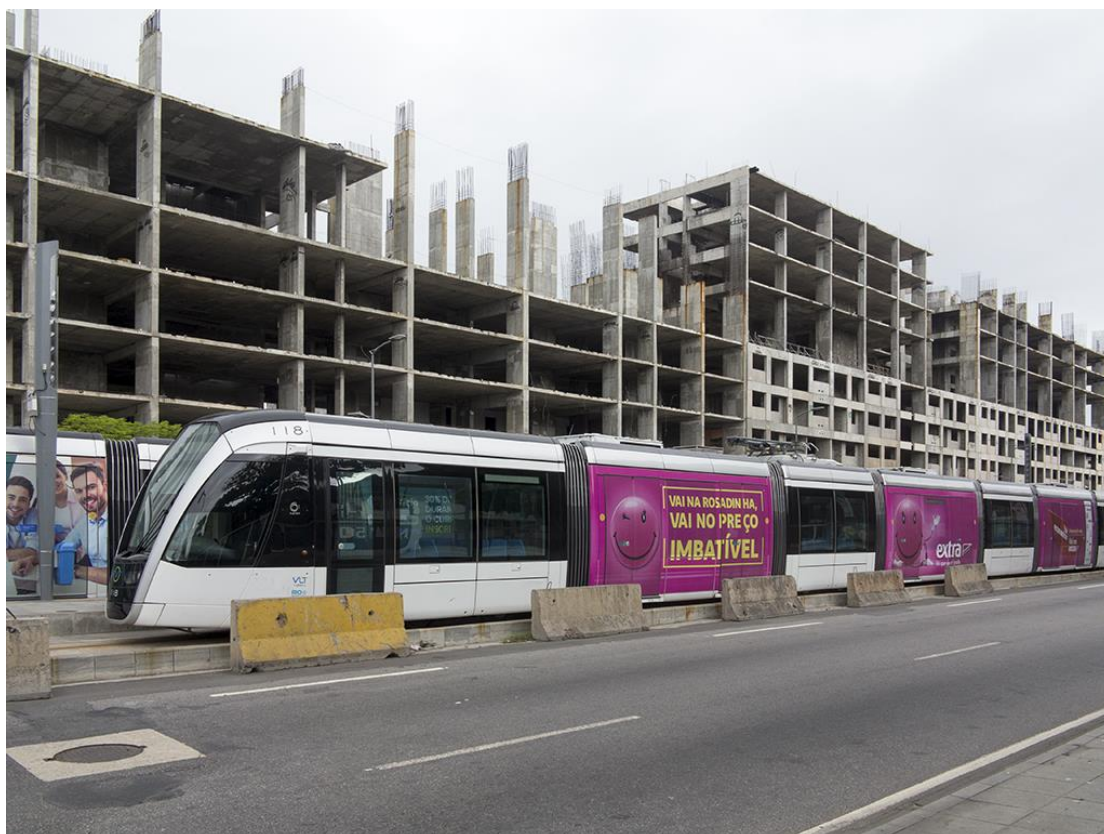
3. O VLT diante do “esqueleto” de concreto, obra da prefeitura, nas proximidades da rodoviária.
