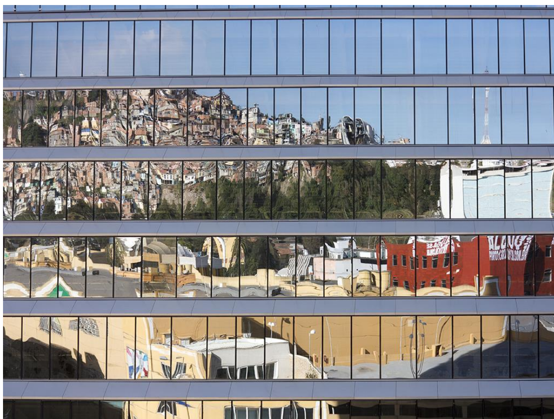
4. Vidros espelhados do Aqwa Corporate, entre as Av. Rodrigues Alves e a via local Av. Oscar Niemeyer. Foto: Angelo A Duarte
