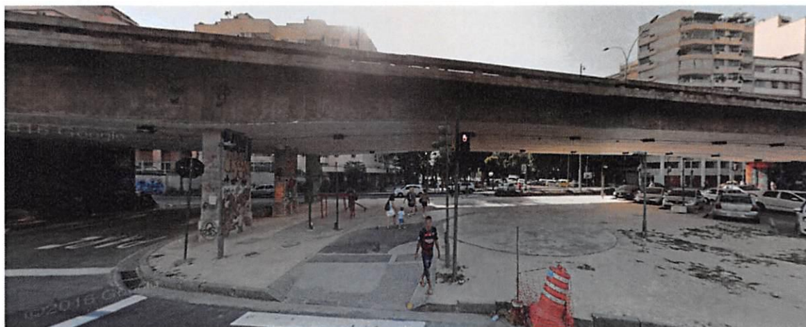
Figura 6 - Vista da praça debaixo do Viaduto Engenheiro Noronha.
