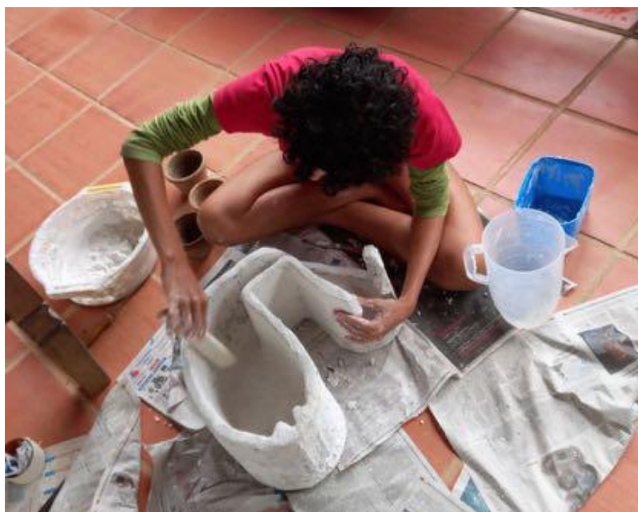
Figura 247 - Aplicação de gesso para o acabamento (arquivo da autora)
