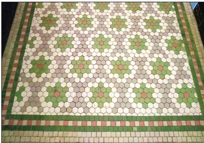
Figuras 19a e 19b: forma hexagonal e revestimento de piso formado por cerâmica, Igreja da Penha.
