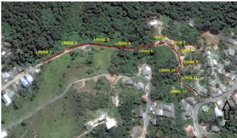
Figura 18: 12 linhas de aquisição de GPR da Rua Mato Grosso. Fonte: Marques (2016).
