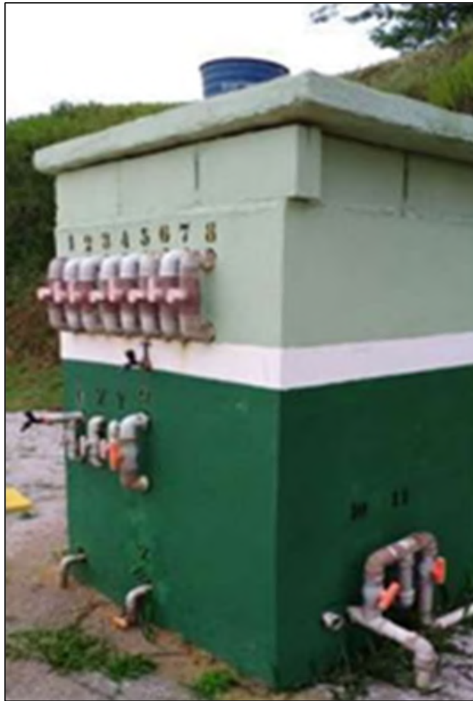
Figura 4: Localização do sistema de tratamento da água (ETA).
