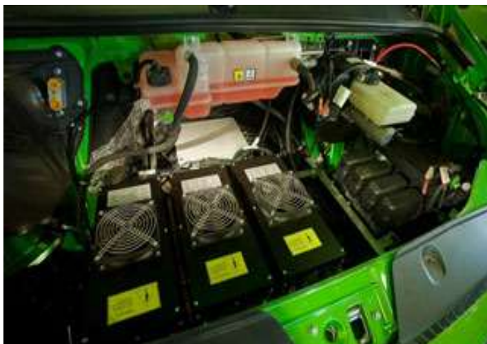
Figura 3.12 Motor e banco de baterias do Daily elétrico.
