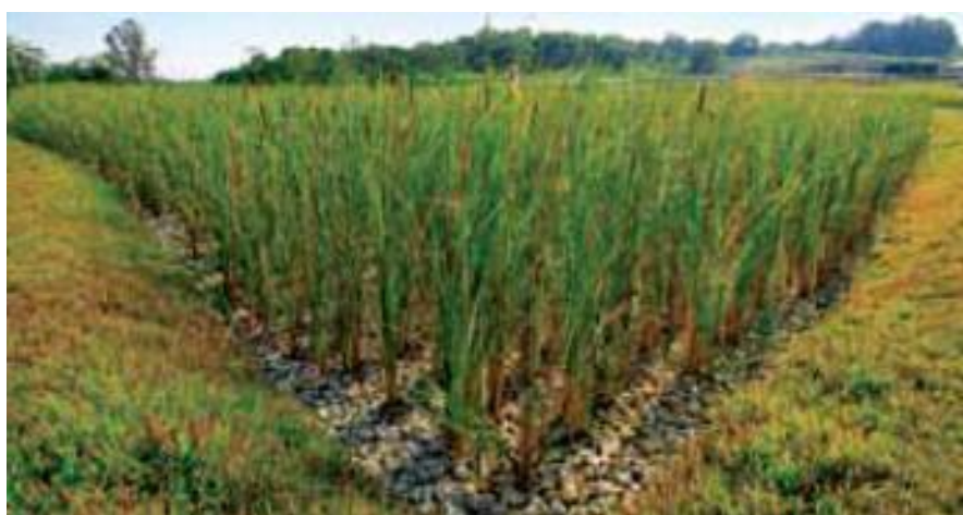
Figura 20: Foto de um alagado com macrófitas emergentes e de fluxo sub-superficial em substrato formado de pedras
