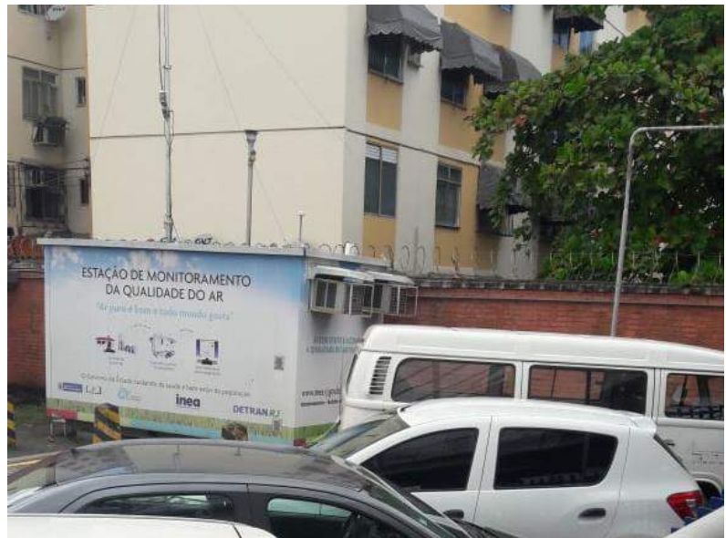
Figura 14: Estação de monitoramento - Taquara
