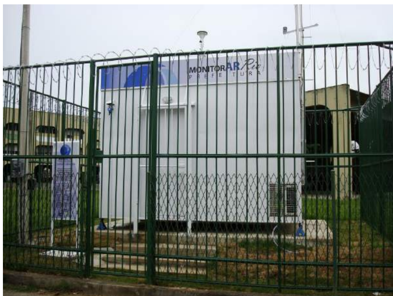
Figura 26: Estação de monitoramento - Campo Grande.
