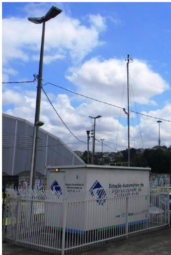
Figura 15: Estação de monitoramento - Centro (INEA)
