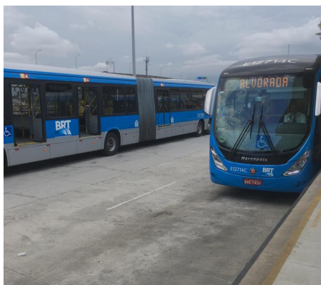
Figura 9: Estação Fundão – BRT Transcarioca – com destaque para via de concreto
