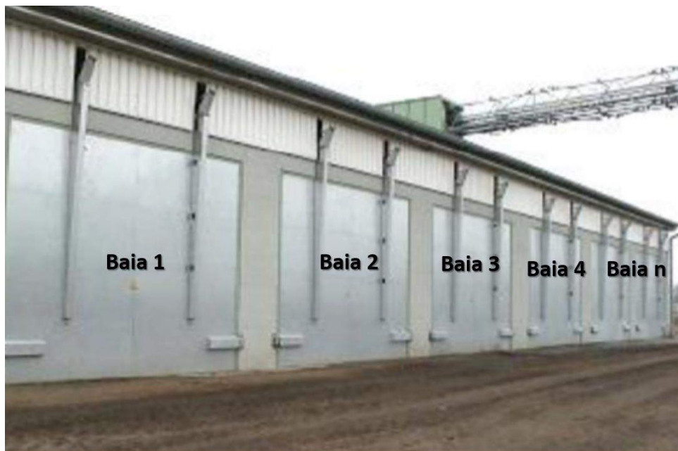
Figura 16: Reator de metanização com tecnologia baseada em processo seco descontínuo - Tipo "garagem" Fonte: BRASIL (2015)
