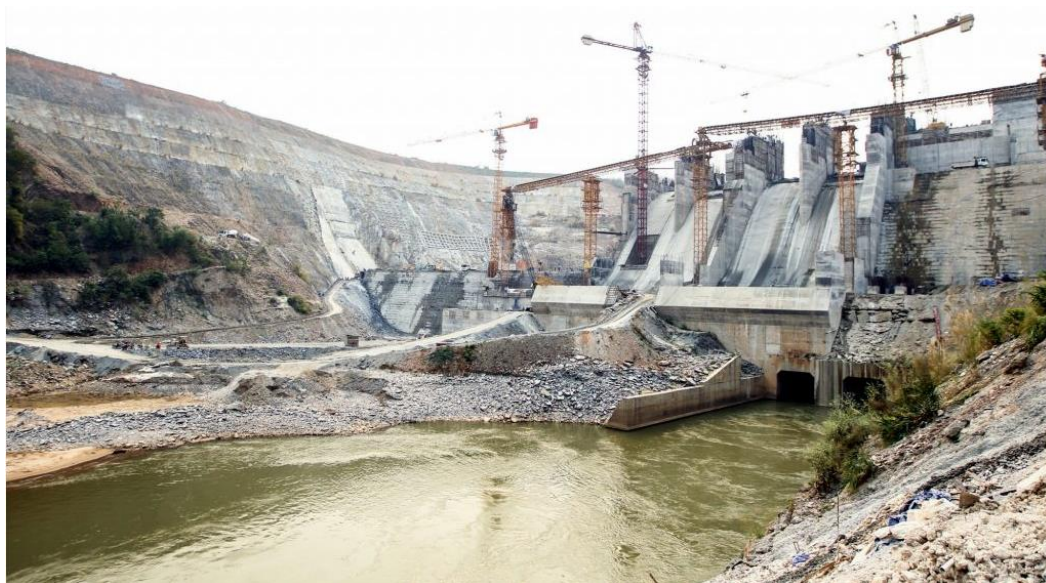
Figura 14: Construção da barragem da TSHPP no Rio Ma.
