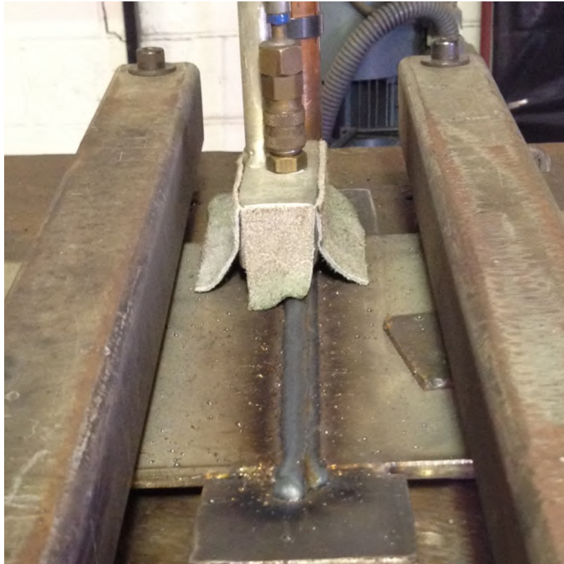
Figura 15: Sistema de trailing gas com uma jaqueta de proteção, auxiliando no confinamento do gás.
