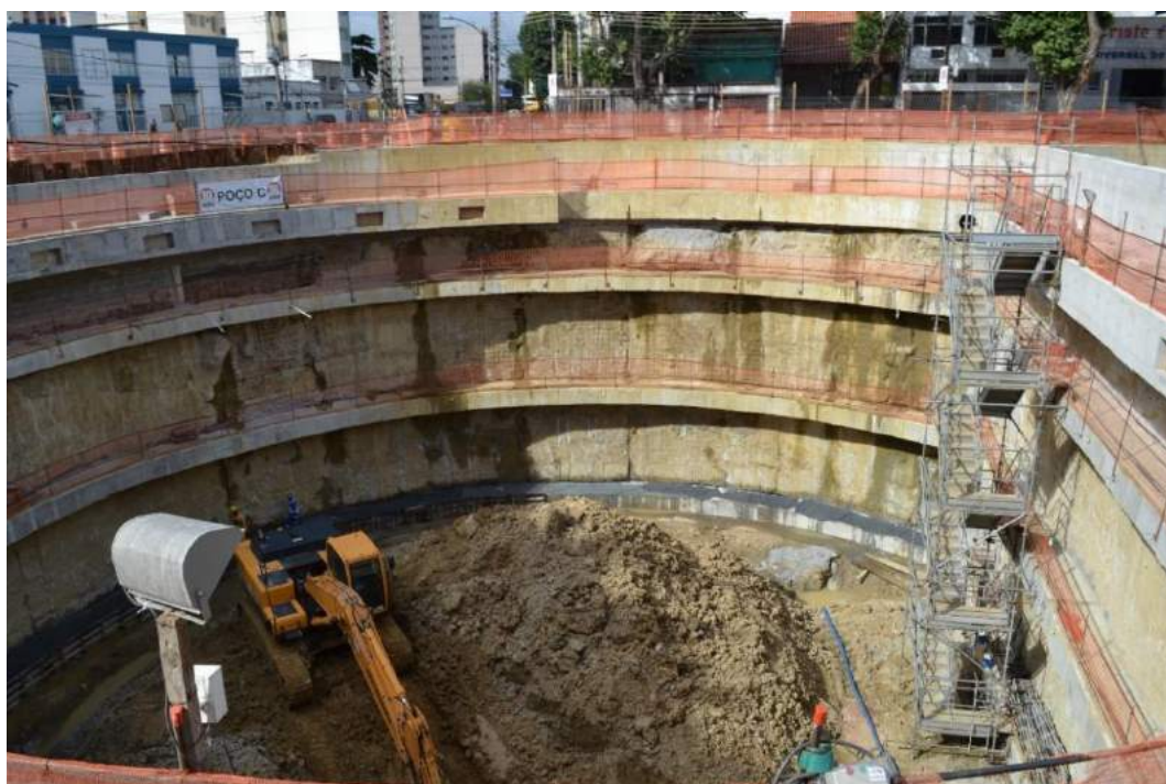
Figura 50 – Construção do poço C na Praça Niterói ao todo são 3 poços (A, B e C), dispostos um ao lado do outro. (Fonte: Autora, foto tirada em 26 de Novembro de 2014)
