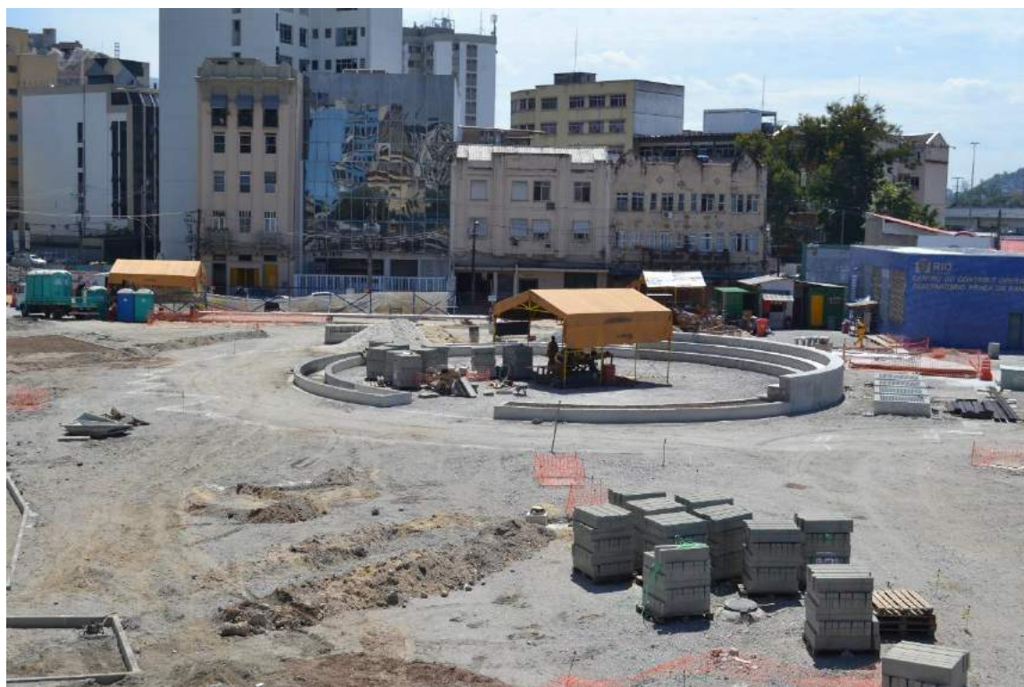
Figura 48 – Parte externa do local de obras da Praça da Bandeira. (Fonte: Autora, foto tirada em 26 de Novembro de 2014)
