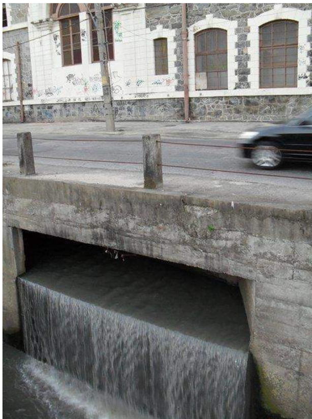
Figura 42 – Galeria do Rio Joana na Rua Maxwell, em frente ao Boulevard. (Fonte: Rio-Águas, 2010)
