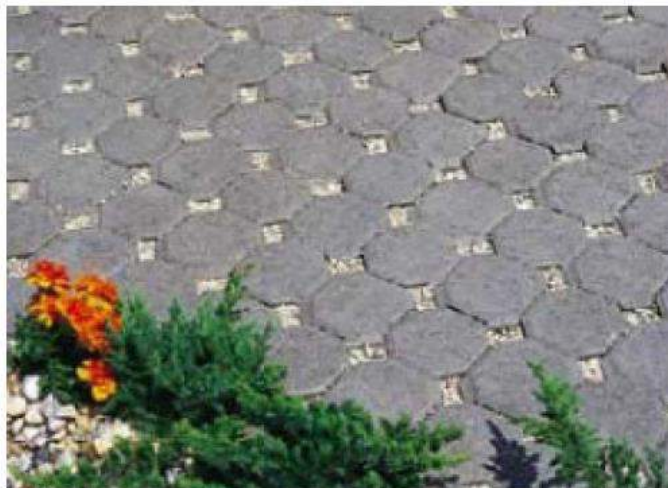
Figura 26 – Blocos vazados permitindo a permeabilidade dos escoamentos. (KOBAYASHI et al. , 2008)
