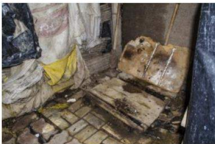
Figura 31 – Banheiro moradora comunidade San Enrique
