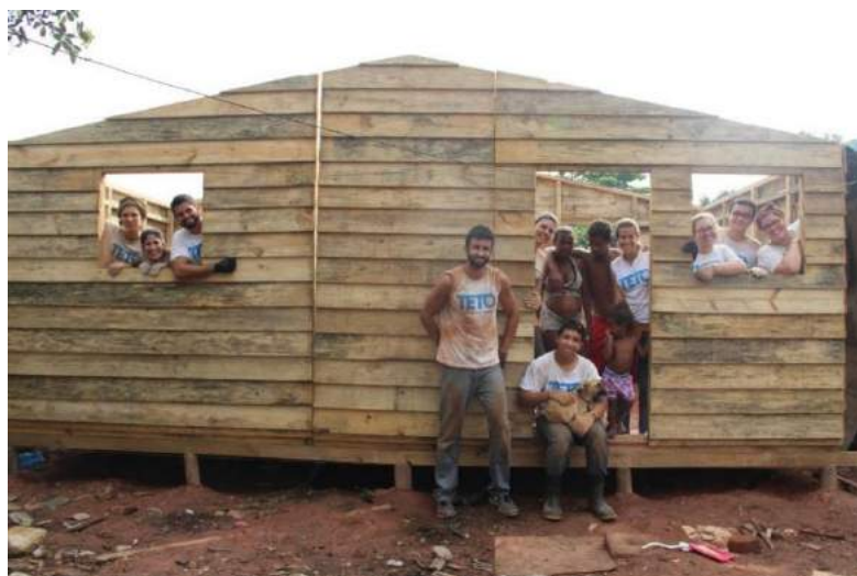
Figura 14 – Finalizado o posicionamento dos Painéis
