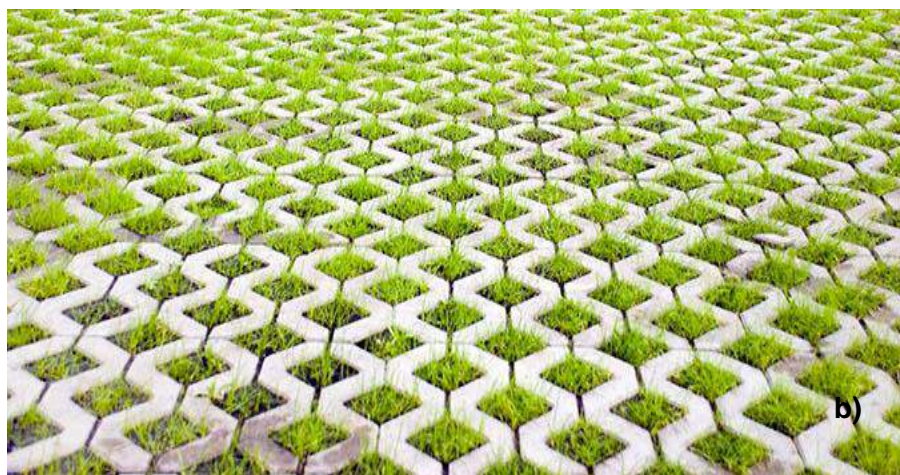
Figura 17. a) Pavimento intertravado poroso e b) pisograma ou concregrama
