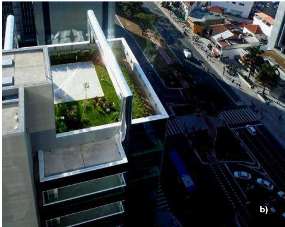
Figura 18. Telhados verdes em: a) Recife e b) São Paulo Fontes: Disponível em: < https://ntcbrasil.com.br/blog/novidade-em-prol-da-sustentabilidade-telhados-verdes/ > e , < https://arvoresdesaopaulo.wordpress.com/2015/06/01/5-telhados-verdes-modernos-na-cidade-de-sao-paulo/ >. Acesso em: 06/09/2016.
