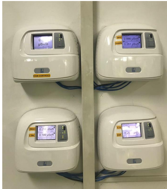
Figura 26. Conjunto de monitores do prédio de produção de radiofármacos do IEN.
