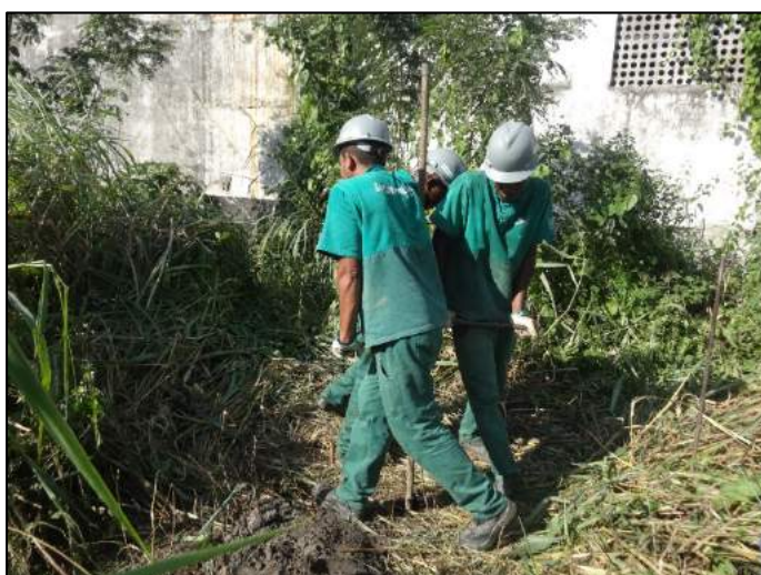
Figura 13: Técnicos realizando uma das sondagens Fonte: Autoria própria.
