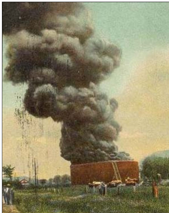
Figura 7.1: Tanque de petróleo cru em chamas no boilover de Colegrove. Fonte: MICHAELIS, 2008.
