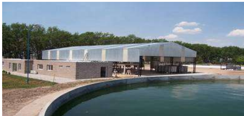
Figura 30: Planta em construção – Oil Fox
