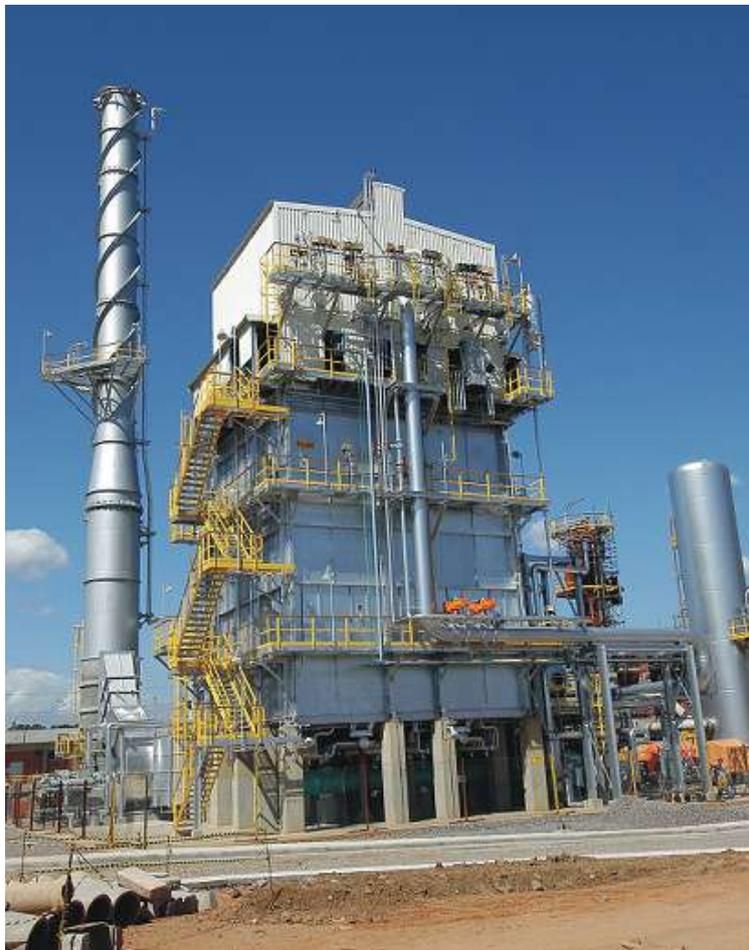
Figura II.6 – Forno de processo sobre pilares
