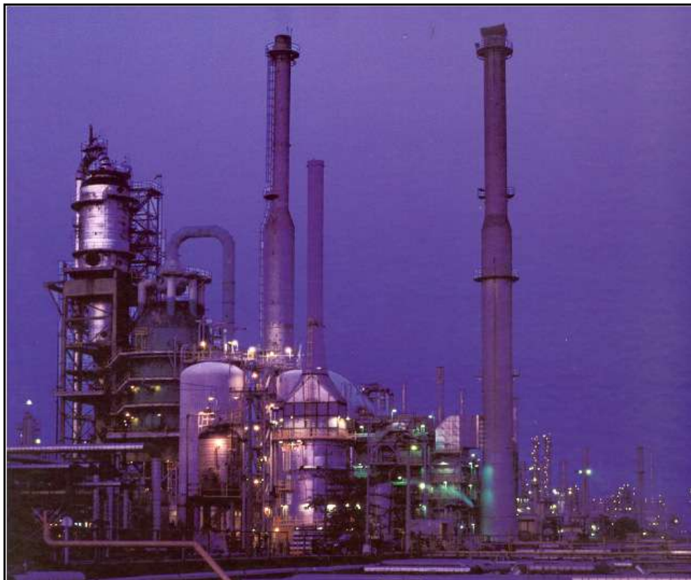
Figura 2.4 - Unidade de Craqueamento Catalítico Fluido da PETROBRAS. Fonte: PETROBRAS (2008c).
