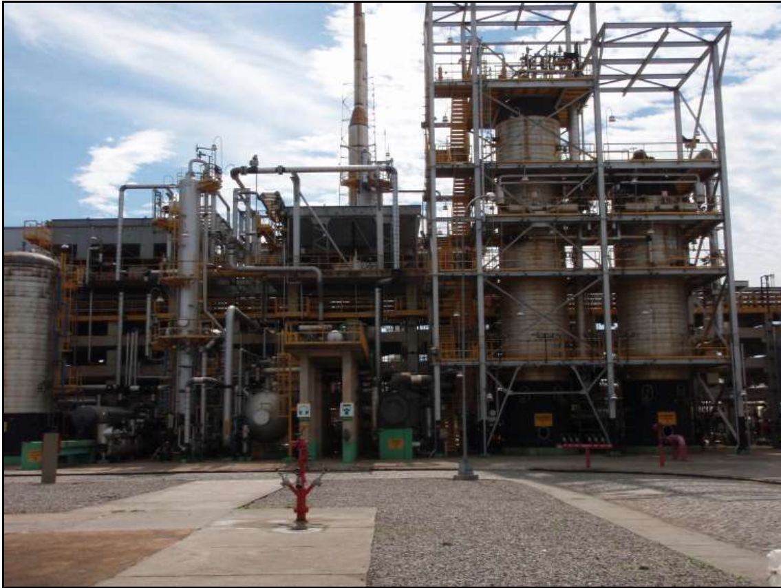
Figura 2.6 - Unidade de Hidrotratamento da PETROBRAS.
