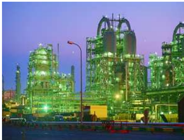
Figura 2-2. Planta da Sasol Synfuels em Secunda, África do Sul (Fonte: Govan Mbeki, 2008)
