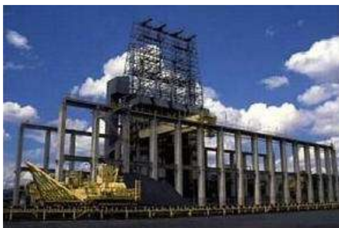
Figura 3-5. Unidade de coque da REGAP (Fonte: Bria, 2004)
