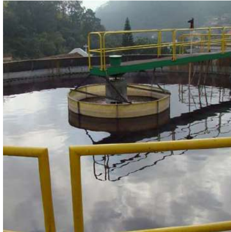
Figura 2.5 – Sedimentador
