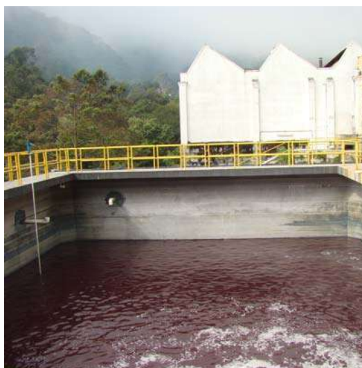
Figura 2.3 – Tanque de equalização vista lateral
