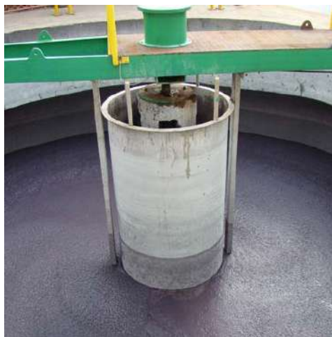
Figura 2.6 – Tanque de adensamento do Lodo
