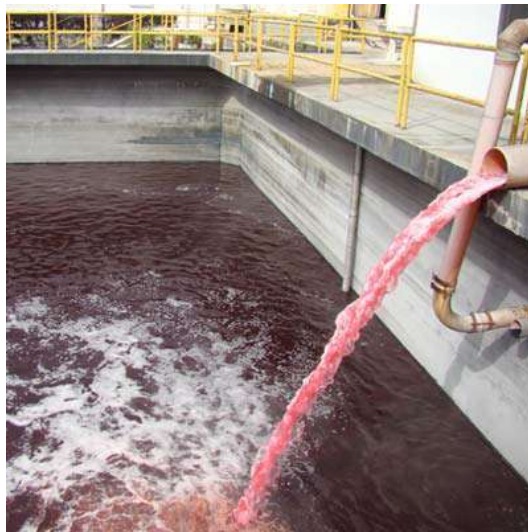
Figura 2.2 – Tanque de equalização sendo preenchido
