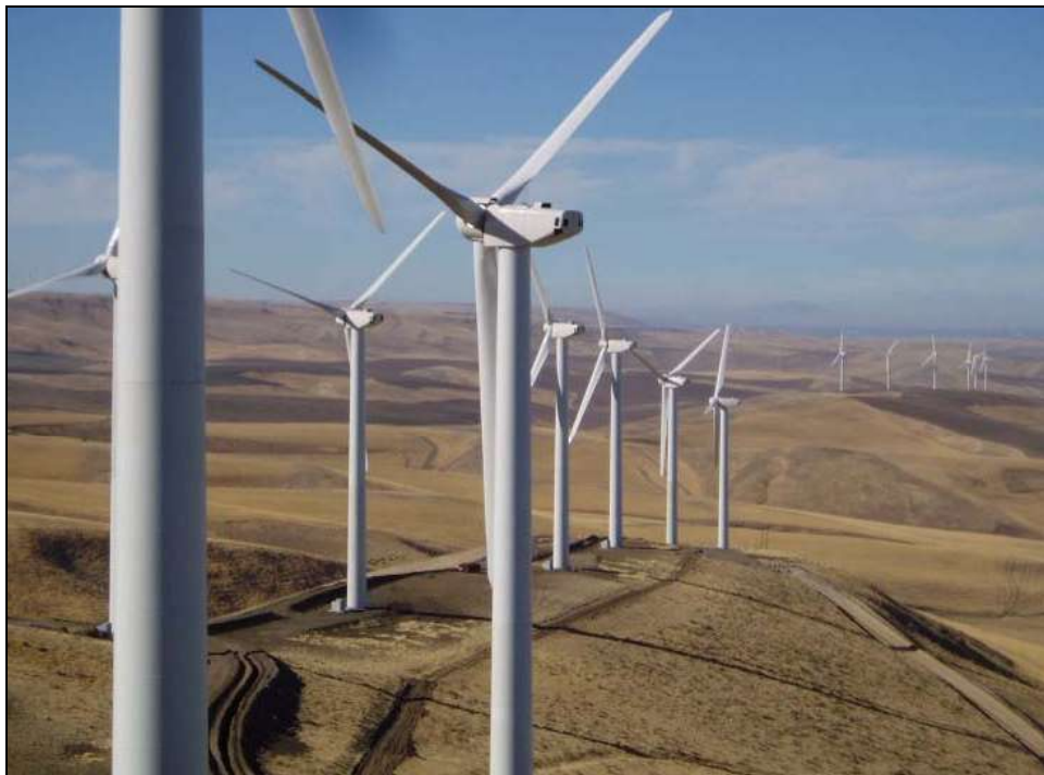
Figura 1.9 – Parque de turbinas. Fonte: CASTRO, 2005.
