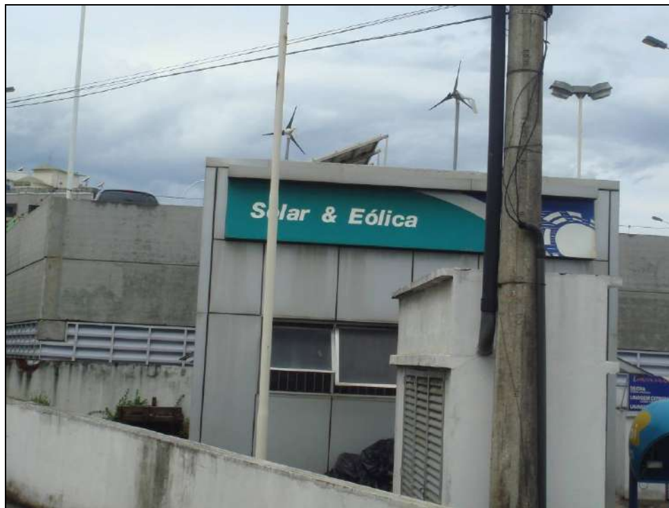
Figura 4.8 – Detalhe do Posto-Escola Macaé.
