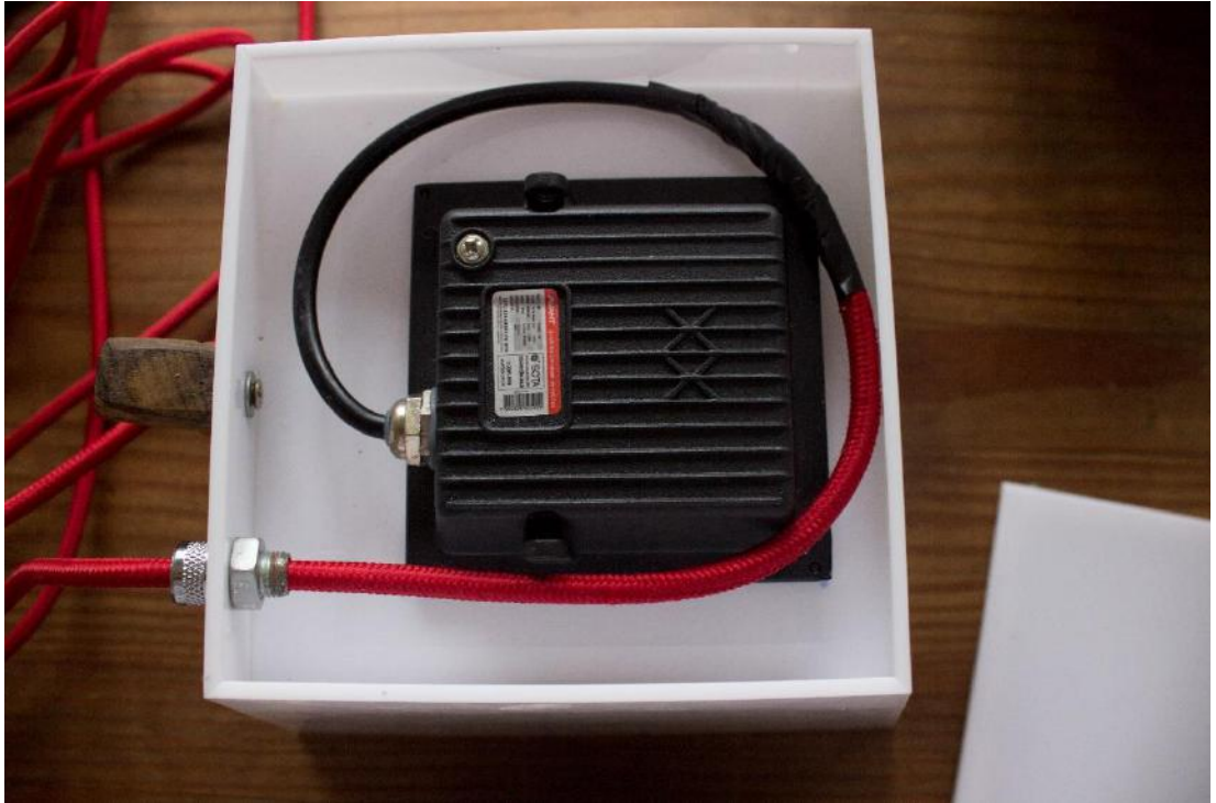
Figura 62 – Fixação do LED e instalação elétrica – Fonte: Elaboração própria
