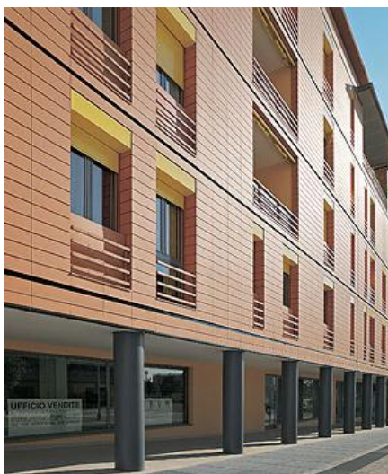
Figura 2.2.4-2: Fachada respirante Fonte: TÉCHNE, 2009
