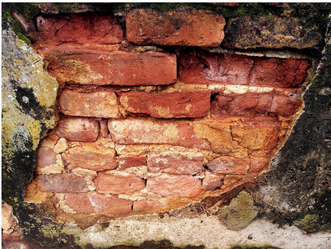
Figura 19 - Detalhe dos tijolos da escadaria que leva do alto do outeiro até a parte baixa do engenho e senzala. 37
