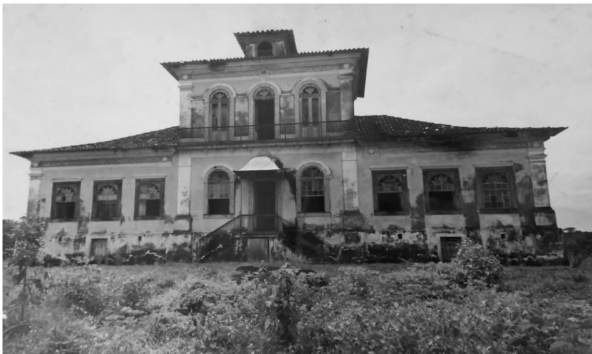
Figura 3 - Fachada da Casa Grande da fazenda São Bernardino. 15
