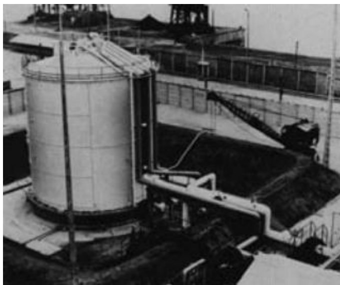
Figura 2: Tanque de GNL de 9% Ni para Gaz de France em Nantes, França – 1960 [1]
