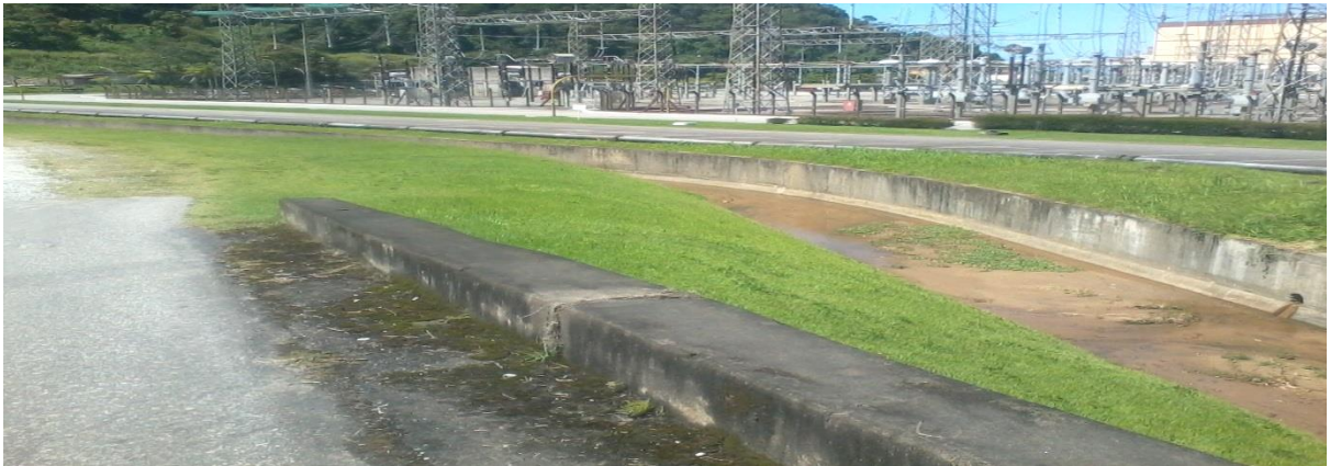
Figura 8- Vista do canal nº 5 da pista lateral
