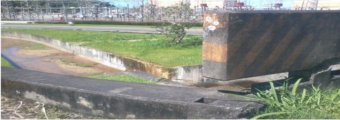
Figura 7- Vista do canal nº 5 estando na ponte
