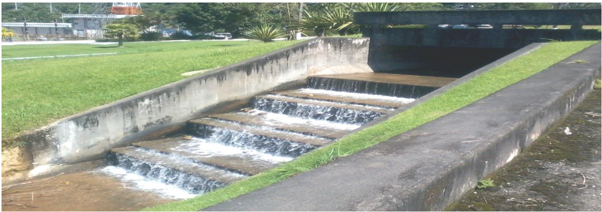
Figura 6- Vista lateral do canal nº 5 da CNAAA com a ponte
