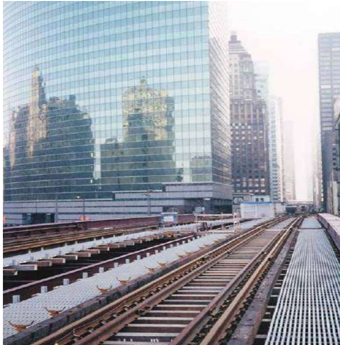
Figura 2.4 – Passadeiras de manutenção das linhas férreas de Chicago.
