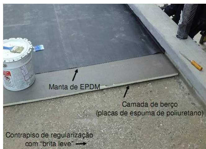
Figura 15: Sistema impermeabilizante com camada de berço
