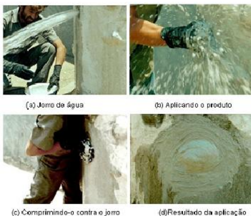
Figura 56, a,b,c,d: Aplicação impermeabilizante de pega ultra-rápida – Fonte: Ventutini, 2008
