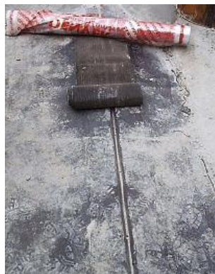
Figura 44: Faixa de manta sendo colada apenas na junta de dilatação – Fonte: Cetimper
