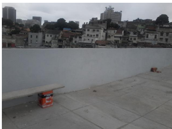
Figura 89: Laje descoberta após impermeabilização – Fonte: O autor
