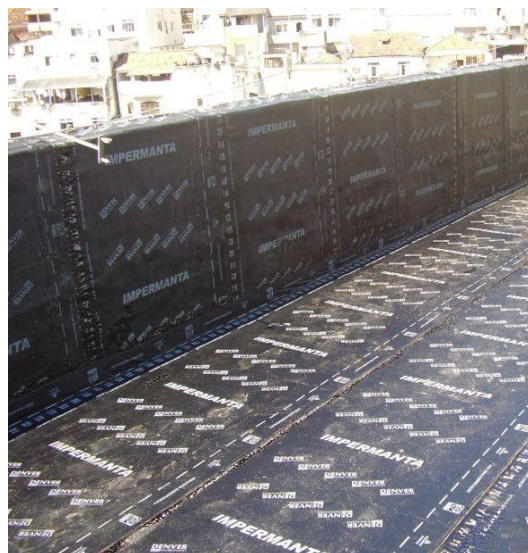
Figura 88: Manta colada por todo o guarda-corpo – Fonte: O autor
