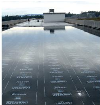
Figura 83: Teste de estanqueidade - Fonte: Métodos executivos de impermeabilização – Freire, 2007
