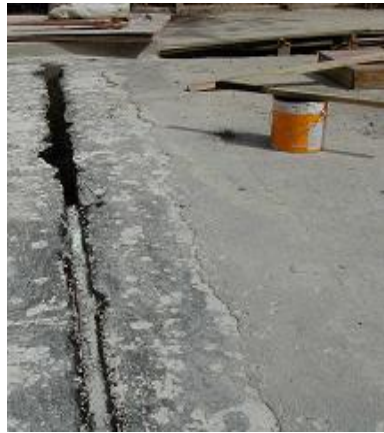
Figura 42: Junta de dilatação com o preenchimento de mástique já iniciado – Fonte: Cetimper
