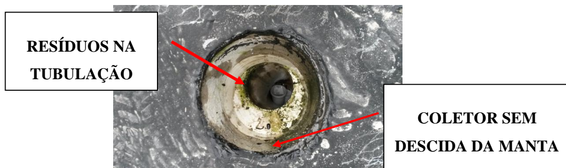
Figura 23: Coletor sem impermeabilização Fonte: O autor
