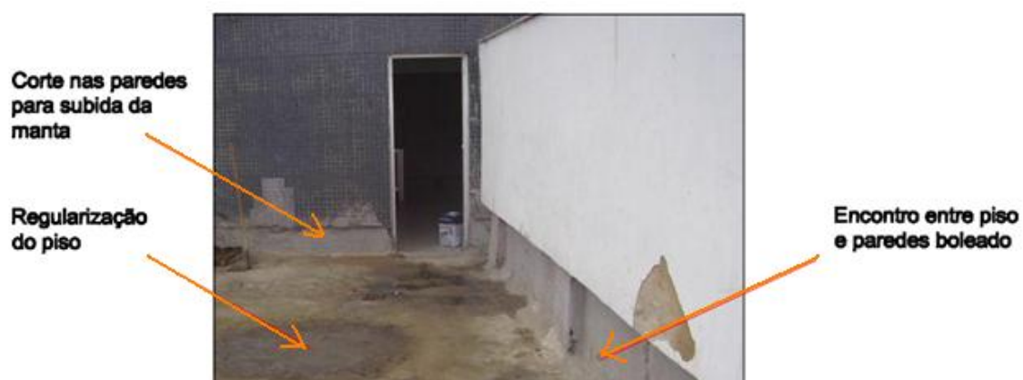
Figura 77: Serviços preliminares para impermeabilização com manta asfáltica - Fonte: O autor
