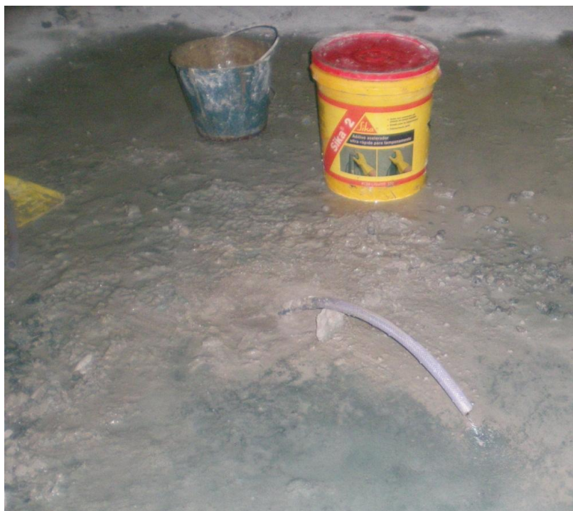
Figura 57: Dreno para tamponamento de vazamento – Fonte: O autor
