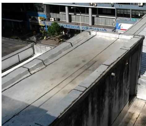
Figura 91: Cobertura com manta asfáltica aluminizada Fonte: O autor
