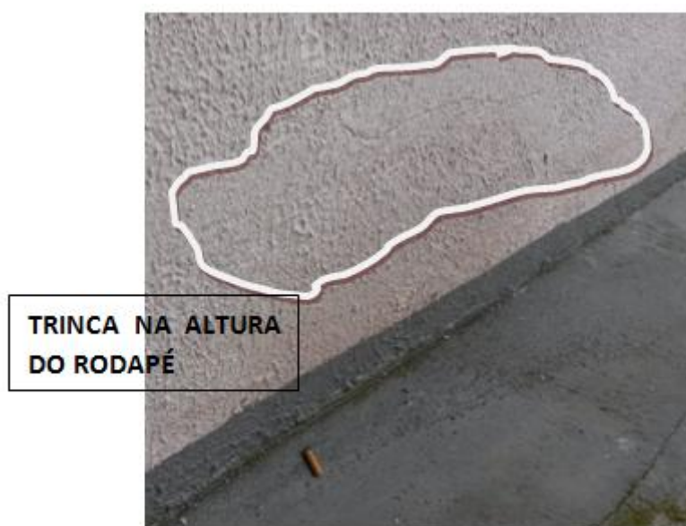
Figura 31: Trinca no emboço na altura do fim do rodapé – Fonte: O autor
