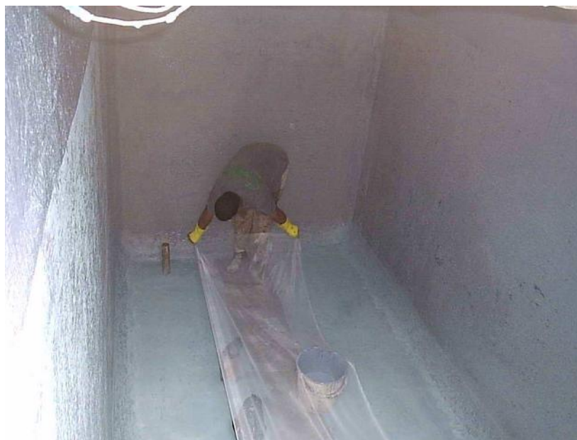
Figura 63: Aplicação de estruturante em reservatório – Fonte: Cetimper
