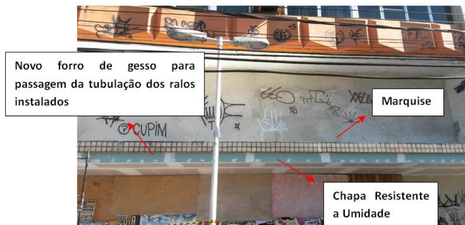
Figura 96: Fachada com marquise de edificação na Ilha do Governador, Rio de Janeiro
