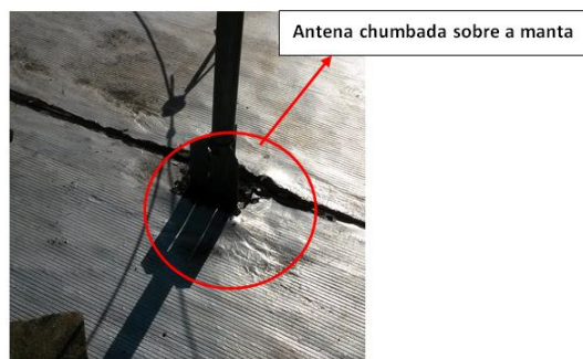
Figura 99: Antena chumbada sobre manta auto-protégida – Fonte: O autor
