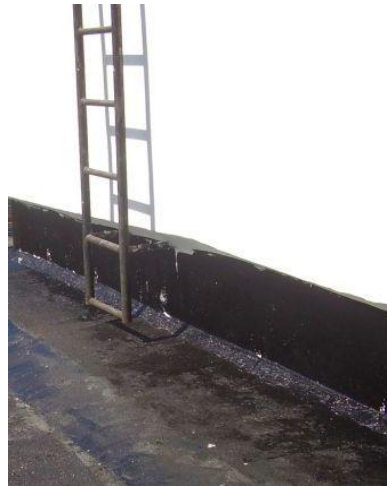
Figura 79: Laje com imprimação já executada - Fonte: O autor
