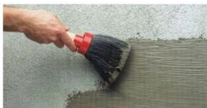
Figura 61: Aplicação de argamassa polimérica à trincha – Fonte: Revista Técnica – Edição 115 - Novembro/2006
