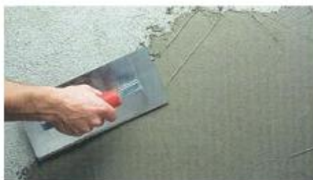
Figura 62: Aplicação de argamassa polimérica com desempenadeira metálica – Fonte: Revista Técnica – Edição 115 - Novembro/2006
