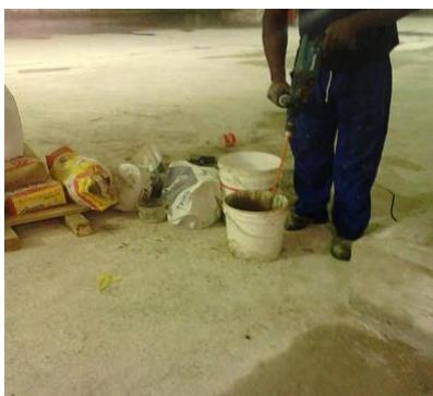
Figura 50: Mistura mecânica do produto – Fonte: O autor
