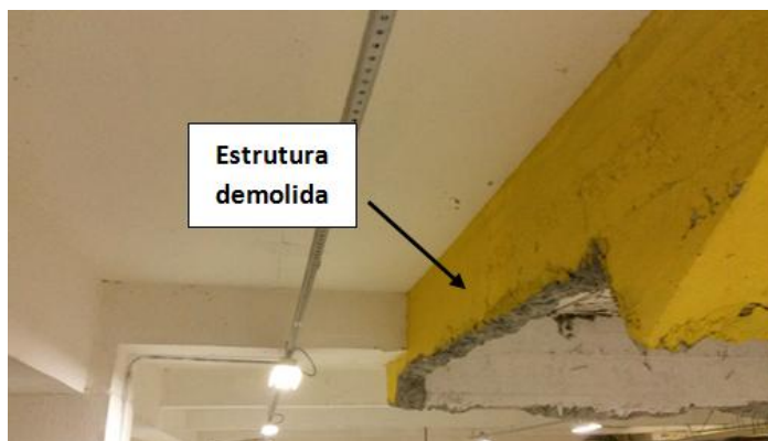
Figura 71: Estrutura demolida para manutenção do pé direito – Fonte: O autor
