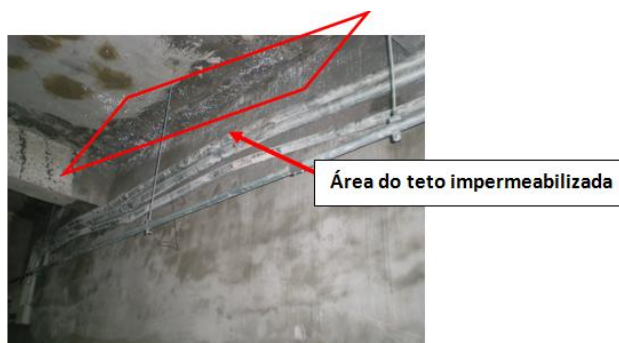
Figura 69: Parede e teto de subsolo impermeabilizadas – Fonte: O autor
