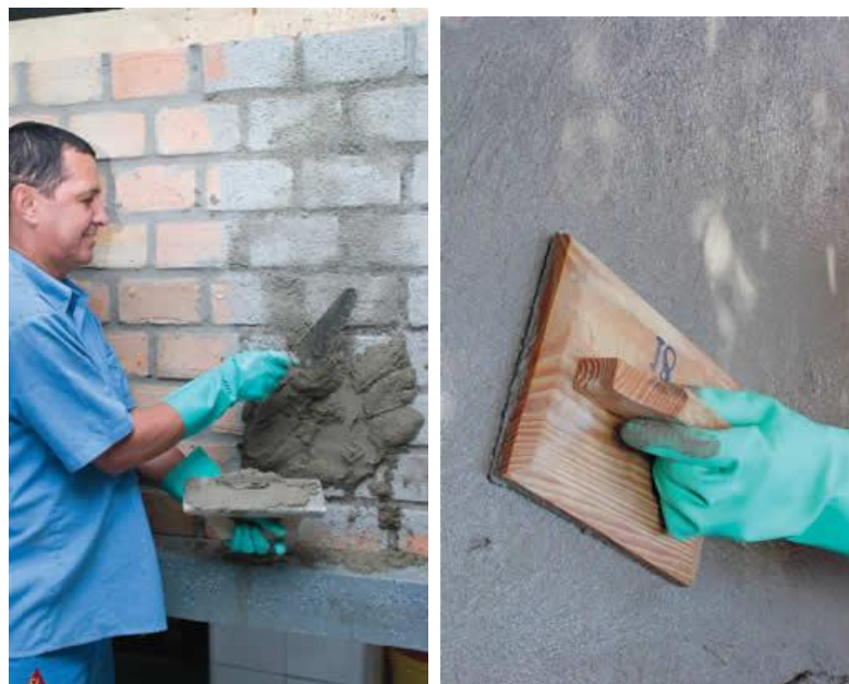
Figura 46: Aplicação de argamassa com colher de pedreiro e desempenadeira de madeira – Fonte: Revista Técnica – Edição 115 - Novembro/2006
