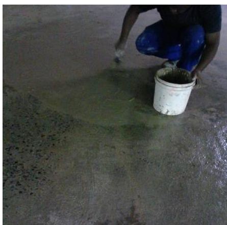
Figura 51: Aplicação com trincha – Fonte: O autor
