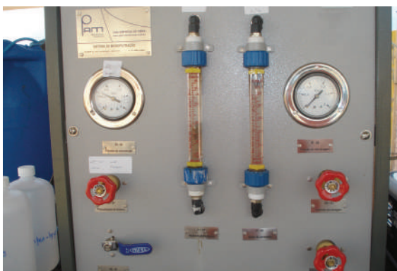
Figura III.1: Vista frontal da unidade de MF.
