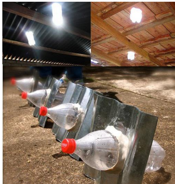
Figura 2.13: Exemplo de tubo reflexivo de resina usando garrafa pet e resina [8].
