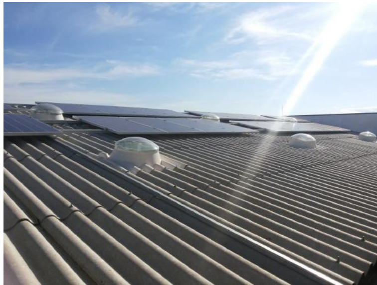
(a) Vista em cima telhado.
