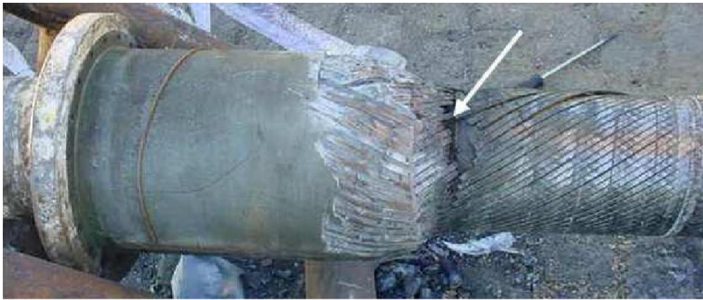
Figura 18 Rompimento dos arames da amadura de tração na região do conector [51]
