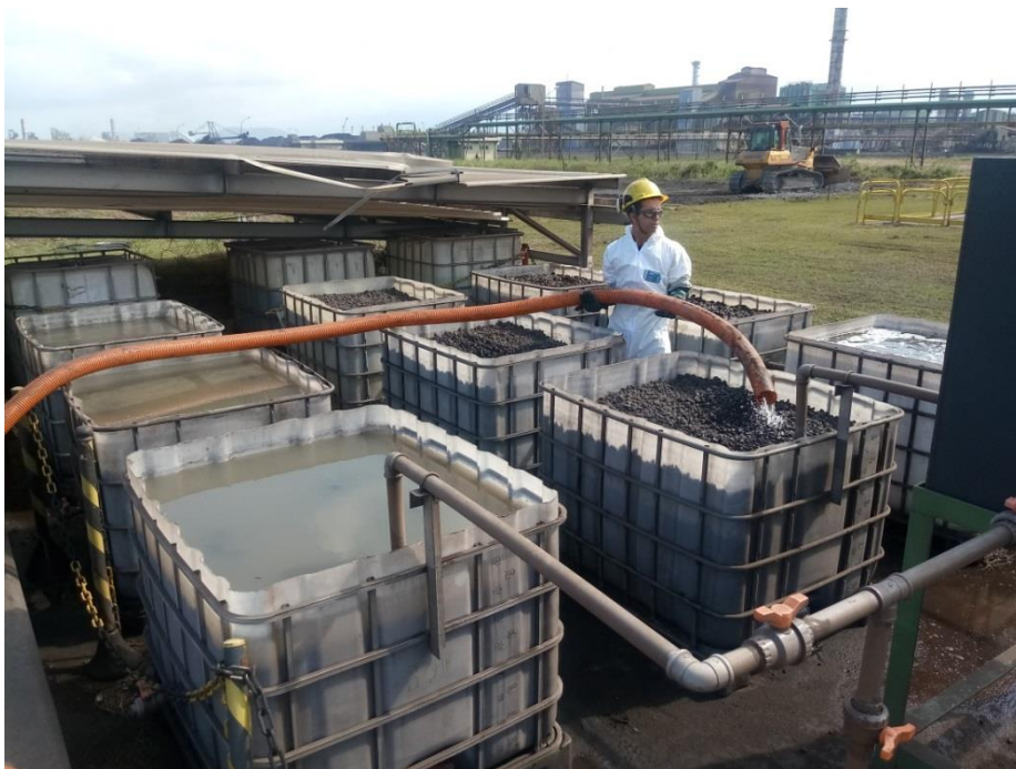
Figura 13 - Estação de tratamento sendo abastecida.
