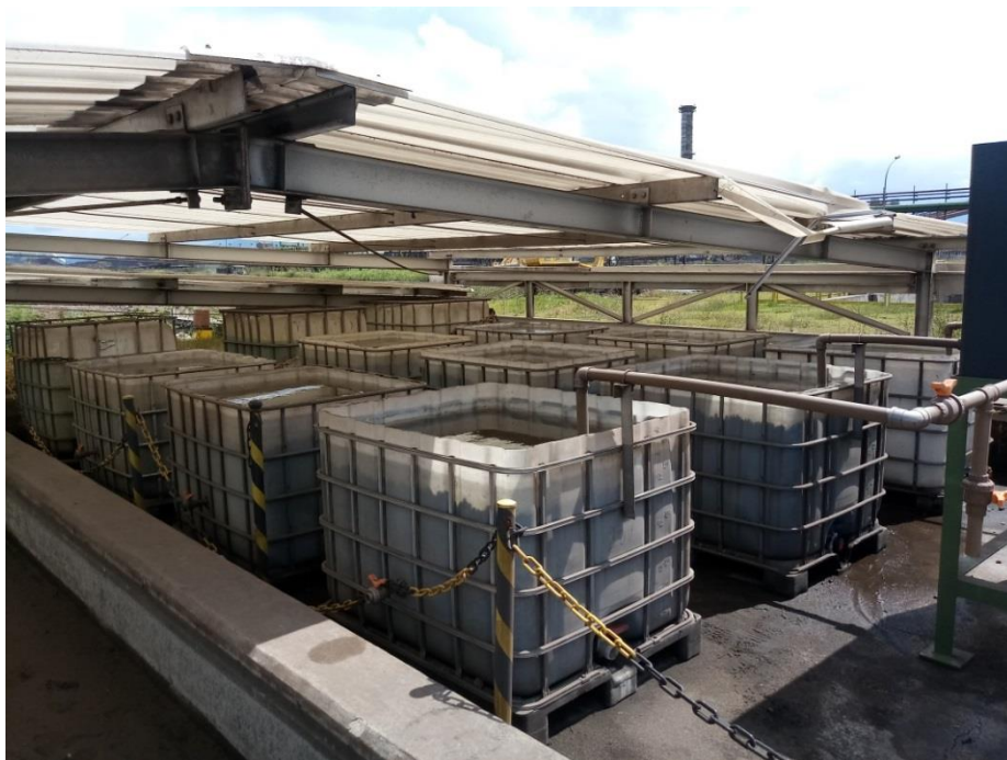
Figura 12 - Estação modelo com cobertura para chuvas.
