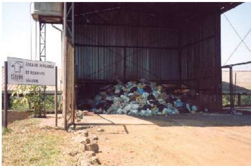
Figura 2.21: Pátio de descarga de resíduos (Barreira, 2005)
