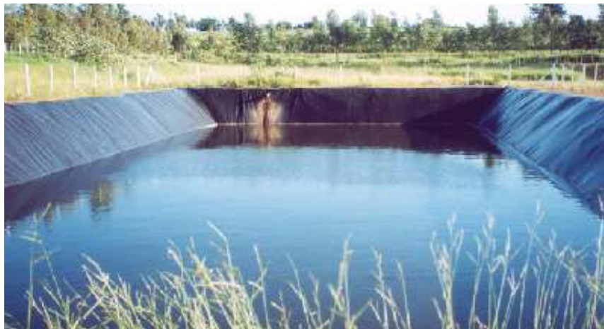
Figura 2.27: Lagoa de estabilização do chorume (Barreira, 2005)
