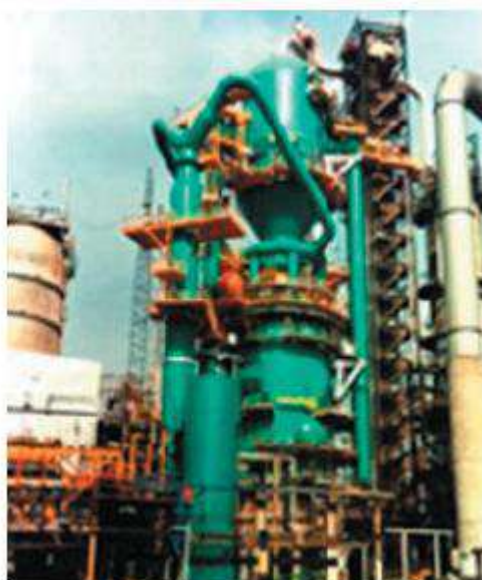
Figura 6.3 – Unidade de FCC com Duplo Riser Externo na REPLAN
