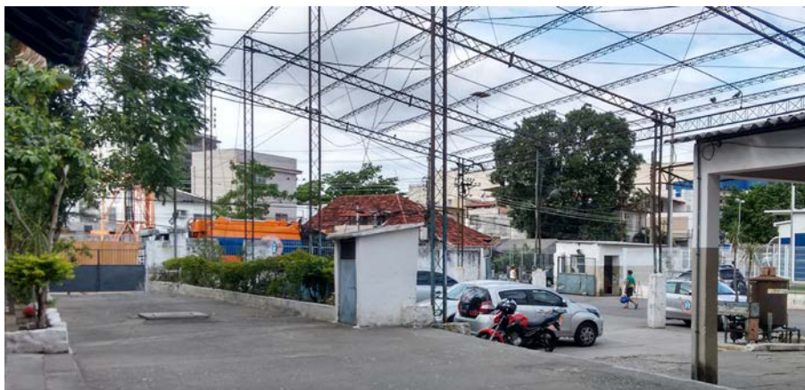
Figura 34: Vista da edificação para a rua Fonte: Autoral, 2019.
