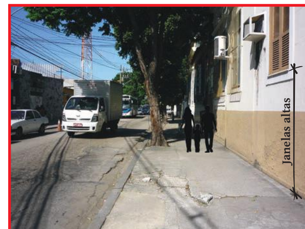
Trecho H-I: As calçadas e vias necessitam de reparo. E em geral tem em edificações baixas e varia entre edificações antigas e gradeadas.
