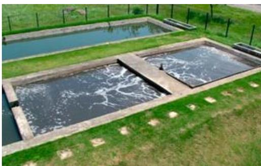
**Figura 6** - Lagoa aerada de uma estação de tratamento de esgoto
