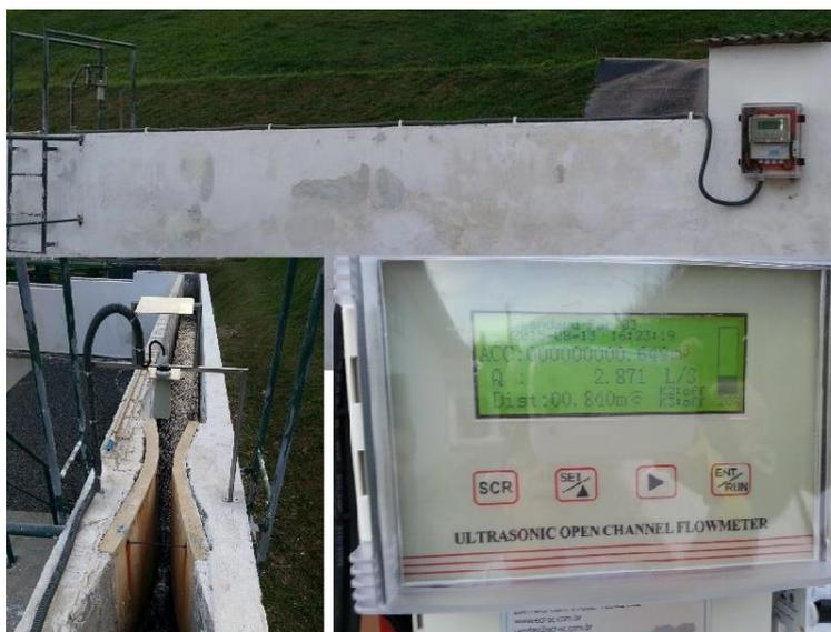
**Figura 24** –Medidor de vazão ultrassônico para canais abertos e calha Parshall
