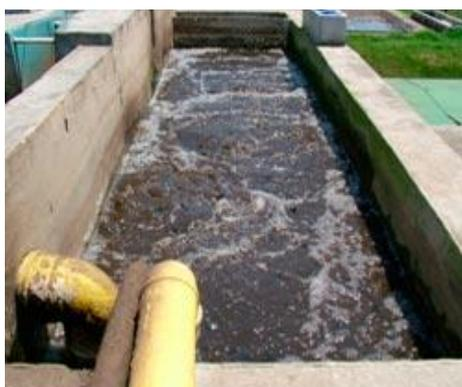
**Figura 7** - Lodo ativado em uma estação de tratamento
