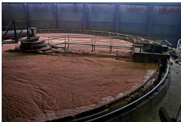
**Figura 4** - Tanque de flotação em estação de tratamento de água
