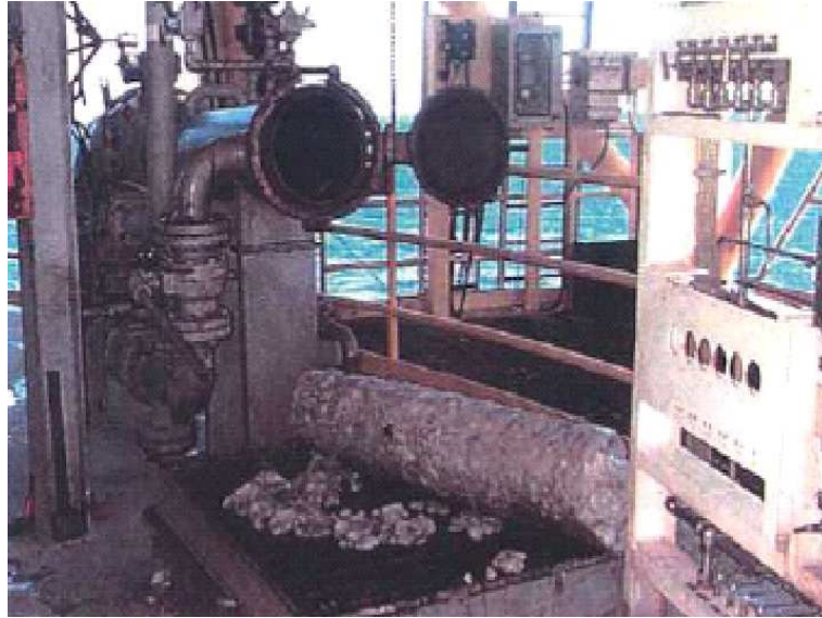
Figura 2.5: Hidratos formados em uma tubulação [1]
