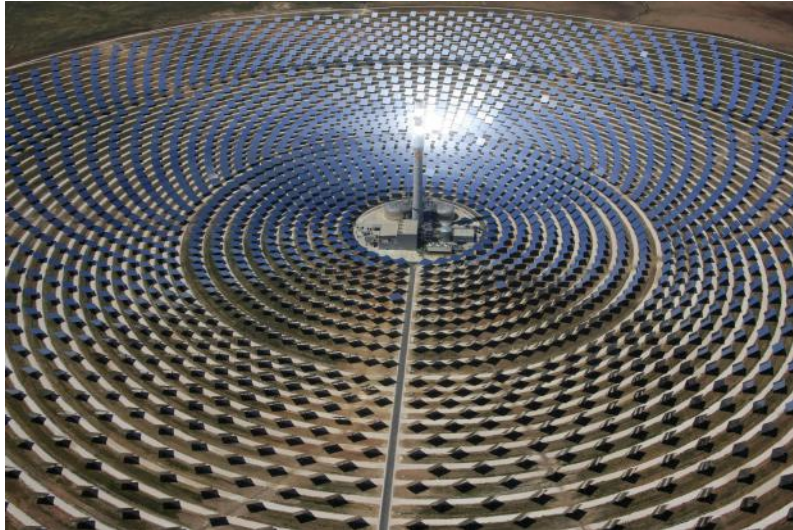
Figura 2.4: Sistema concentrador do tipo torre de potência solar – solar power tower . Fonte: www.sener-power-process.com .
