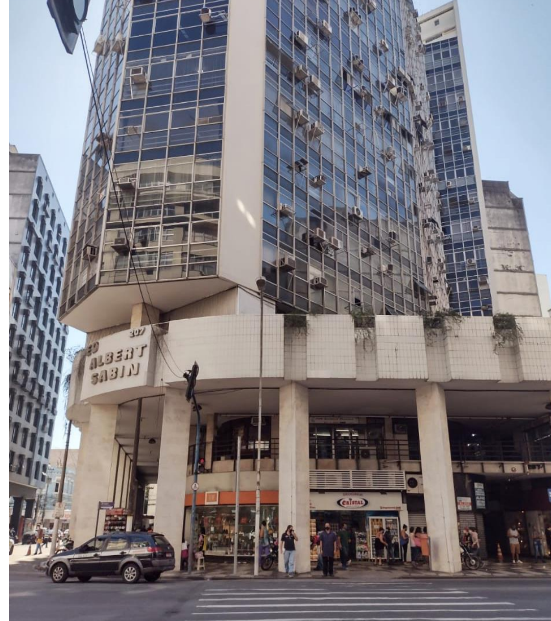
Edifício Albert Sabin, na Avenida Amaral Peixoto
