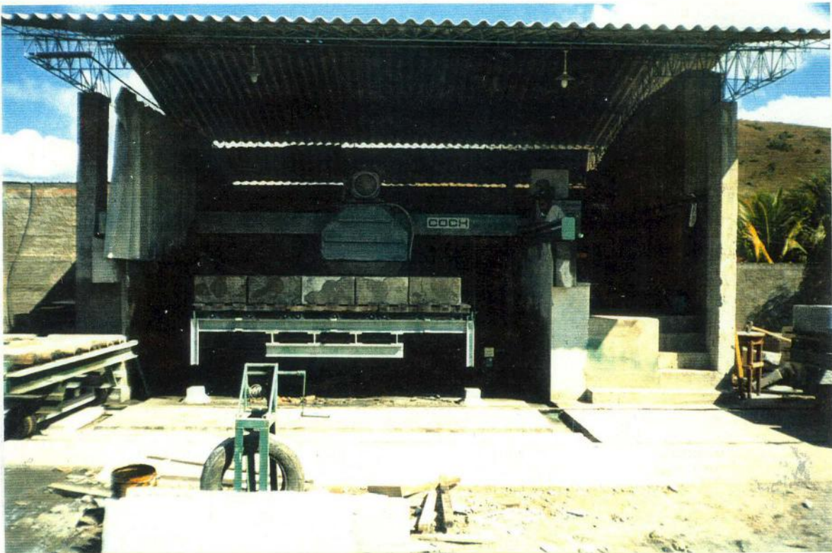
Fotografia 24: Verifica-se acima a serra-ponte em operação.
