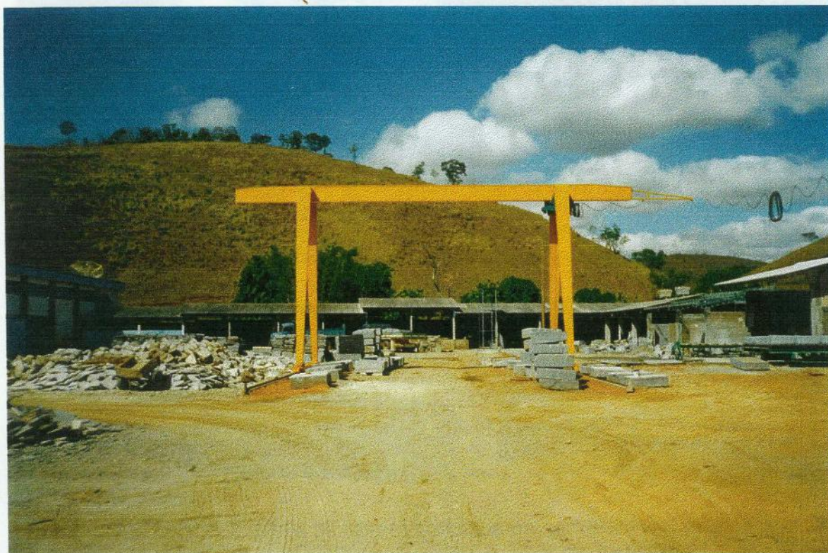
Fotografia 19: Outra visão do pórtico acima mencionado.
