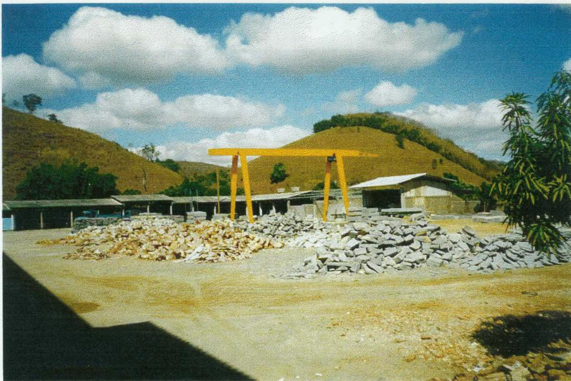
Fotografia 18: Vista geral do galpão da serraria do grupo Pedras Paraíso. Observa-se no centro uma estrutura metálica amarela chamada "pórtico" utilizada na remoção e transporte dos blocos dos caminhões para os carros de alimentação.
