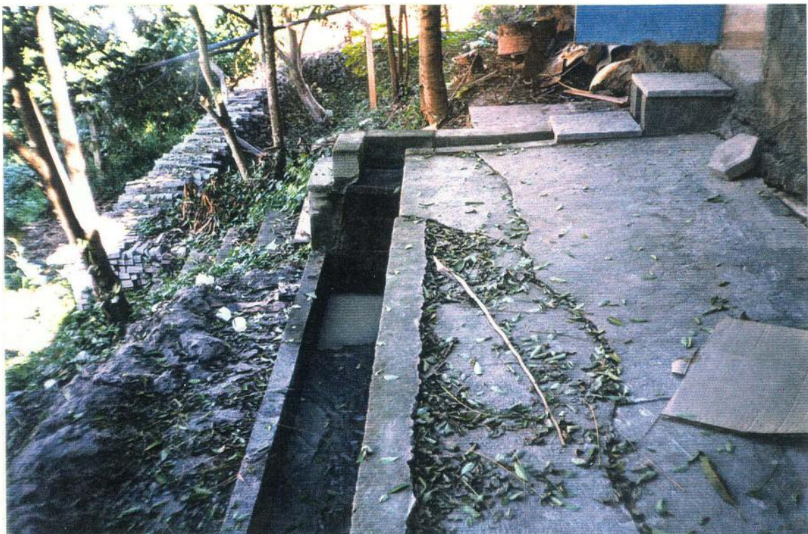
Fotografia 25: Fundos do galpão da serraria do grupo Pedras Paraíso. Observar o tanque de decantação feito com a finalidade de reter o material mais grosso, a fim de que não seja transportado para o rio situado logo abaixo.
