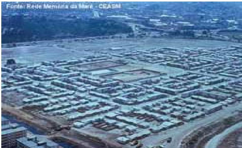
Imagem 47: Construção da Vila do João, anos 80.
