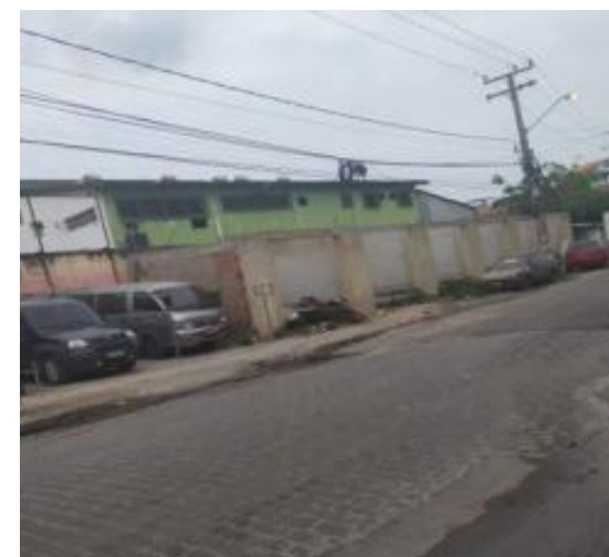
Imagem 40: Calçada do Museu, fachada sudoeste.
